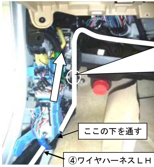
写真22. JBボックス付近配線
